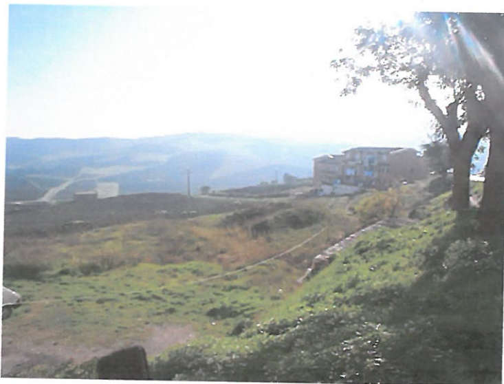
Versante ad Est della Murgiacolor ,con opera di sostegno
