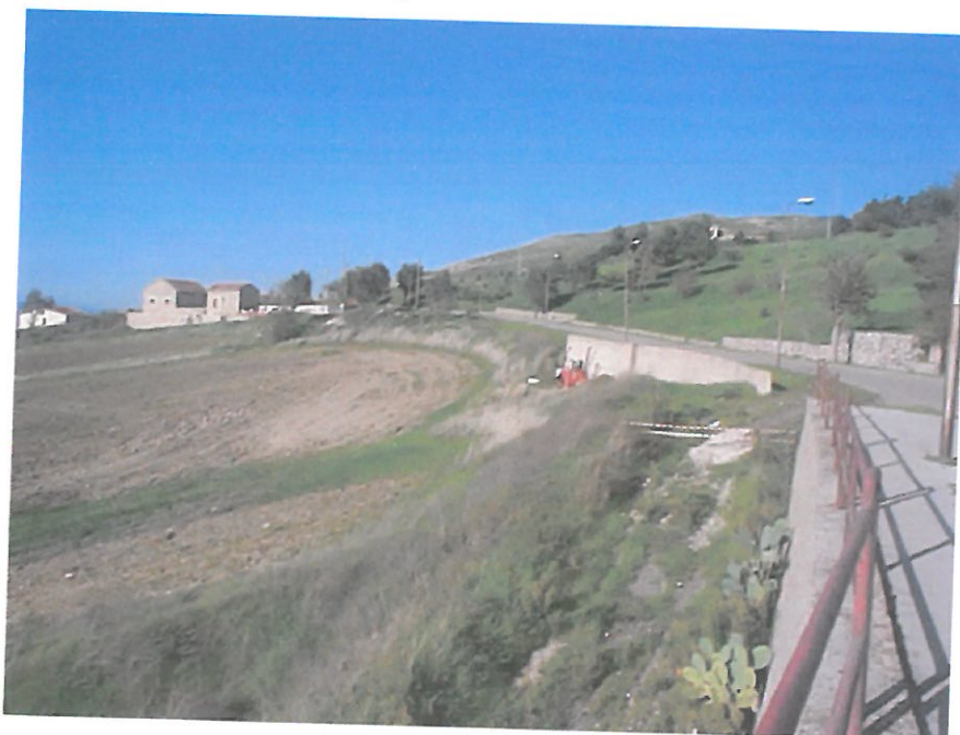
Via della Rimembranza con sottostante frana e diaframma a monte.
