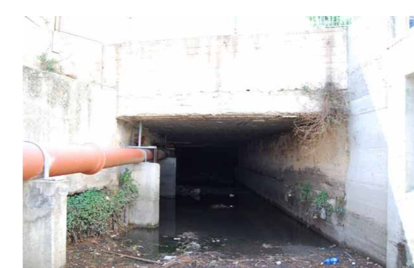
Foto n.16 - Attr. n.7 - Inizio tratto canale tombato
