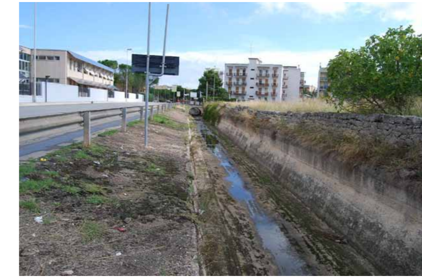
Foto n.9 - Tratto canale a cielo aperto
