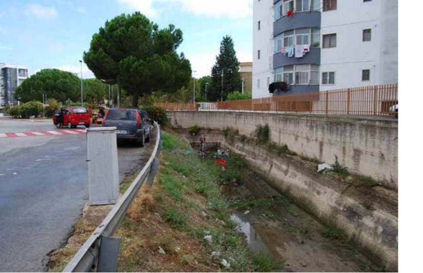
Foto n.12 - Tratto canale a cielo aperto
