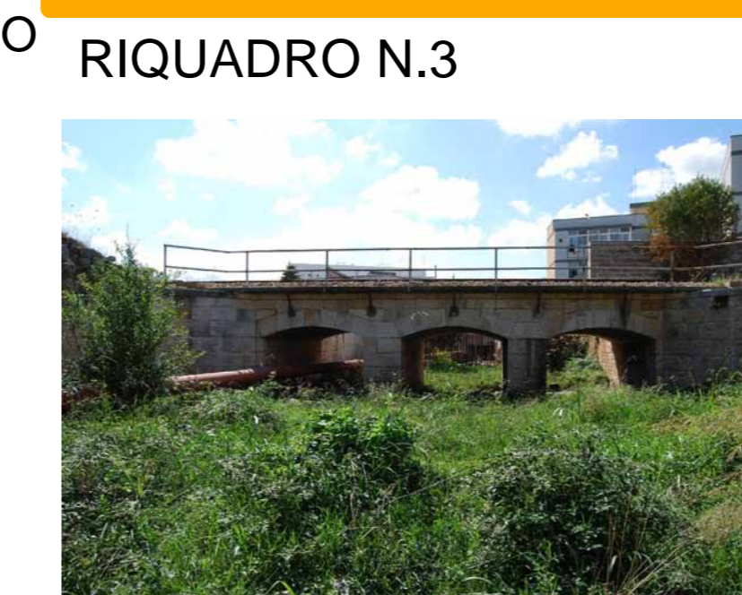
Foto n.19 - Attr. n. 8 - Attraversamento ferroviario
