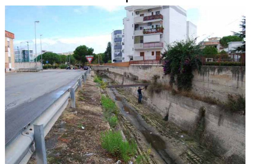
Foto n.11 - Tratto canale a cielo aperto
