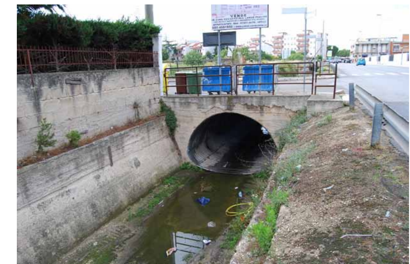
Foto n.10 - Attr. n.5 Fine canale tombato - Condotta ARMCO
