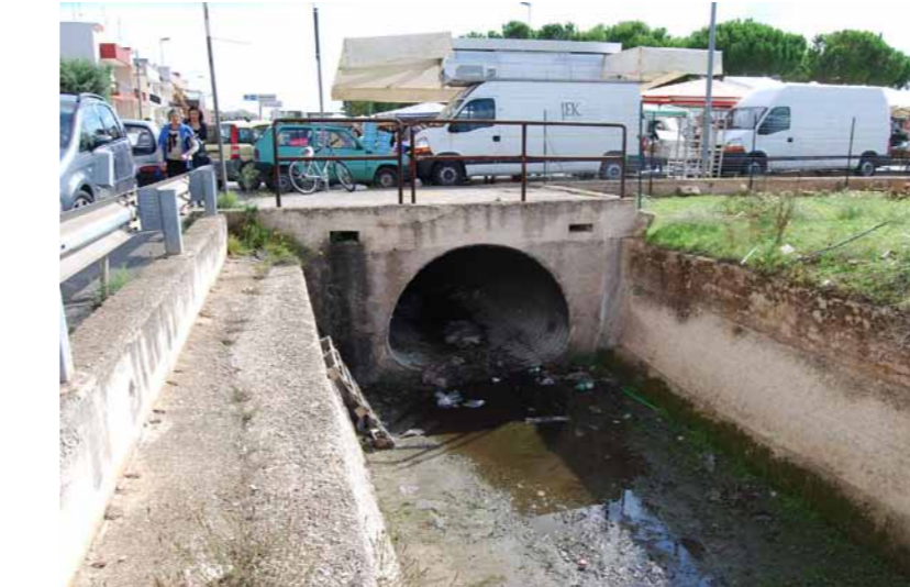
Foto n.5 - Attr. n.3 - Condotta ARMCO - Inizio tratto canale tombato
