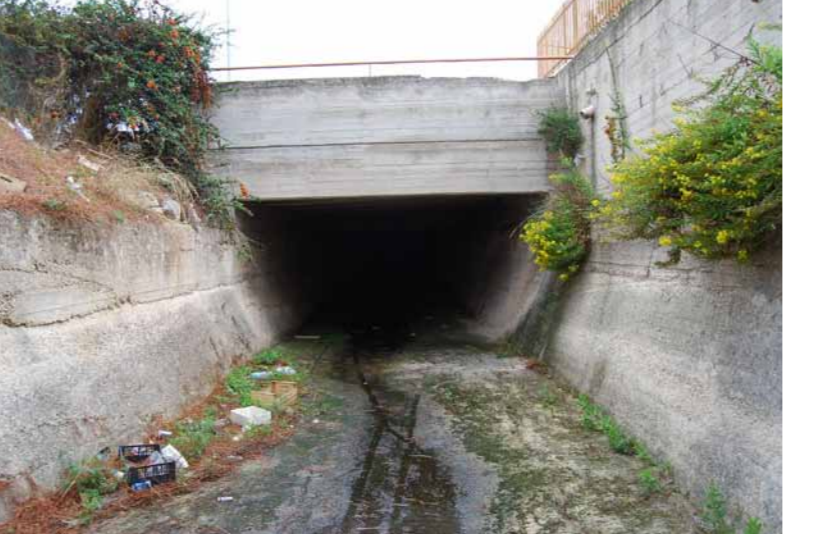
Foto n.13 - Inizio tratto canale tombato
