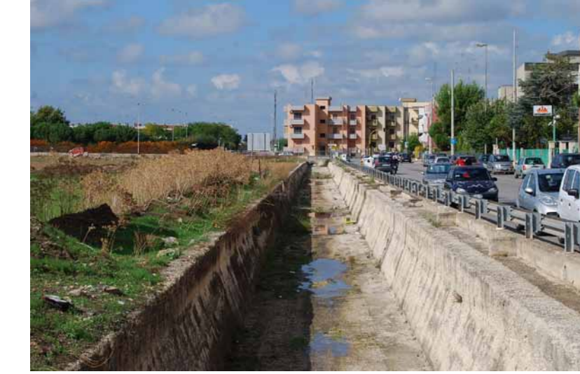
Foto n.1 - Parte iniziale canale a cielo aperto
