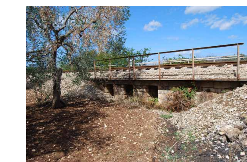
Foto n.23 - Attr. n.9 Attraversamento ferroviario
