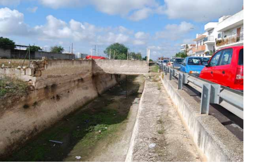
Foto n.4 - Attr. n.2 - Accesso proprietà privata
