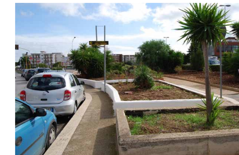
Foto n.6 - Tratto di canale tombato
