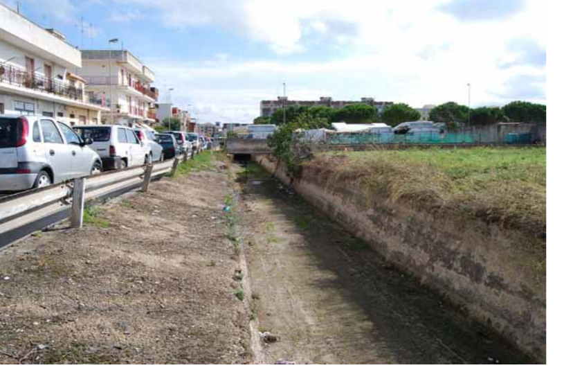
Foto n.3 - Canale a cielo aperto
