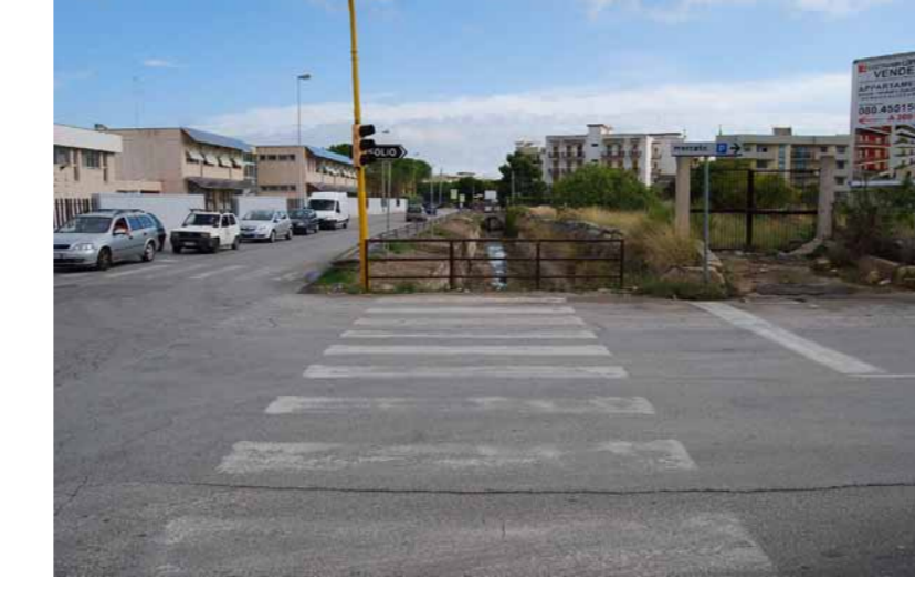
Foto n.7 - Fine tratto di canale tombato
