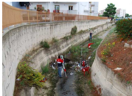
Griglia all'interno dell'alveo a monte dell'intersezione di Largo Piscine
