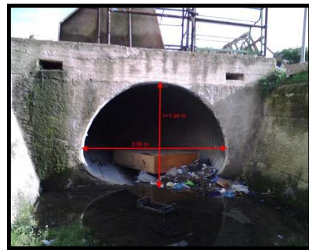
Attraversamento 3: Intersezione via Ugo Foscolo (inizio di un tratto tombato in Via Aldo Moro di lunghezza 215 m)
