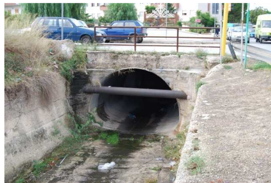
Sezione di valle Attraversamento 3: intersezione di una condotta
